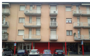
OSIO SOTTO Zona Centrale
